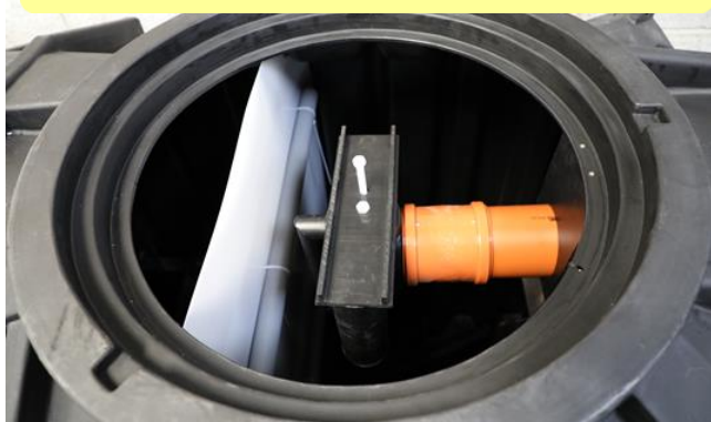
Séparateur et valve de restriction dans la FTE
