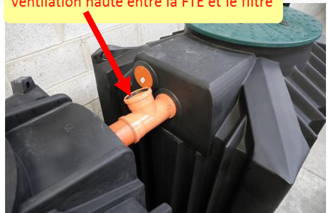
Ventilation haute entre la FTE et le filtre
