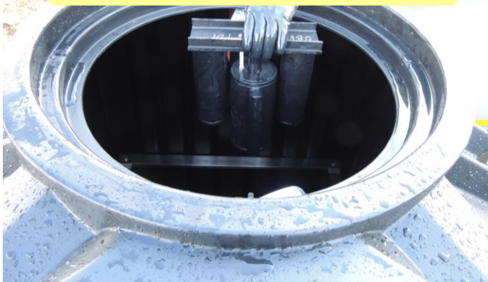
Valve de restriction dans la FTE N°2
